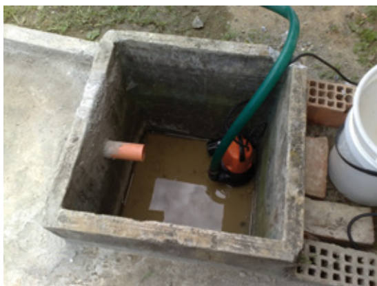
Pozzetto di raccolta delle acque
