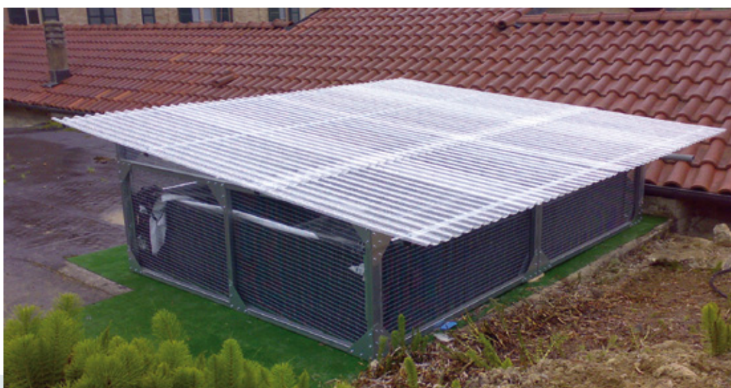
Sistema per la gestione dei reflui di prodotti fitosanitari. (Heliosec®)
